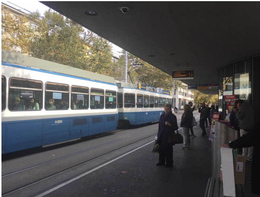
Bild 39: Haltestelle Limmatplatz, Zürich: genügend Warteraum, erhöhte Haltestellenkante
